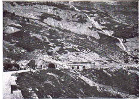
Route du Simplon : La galerie du Kaltwasser.
