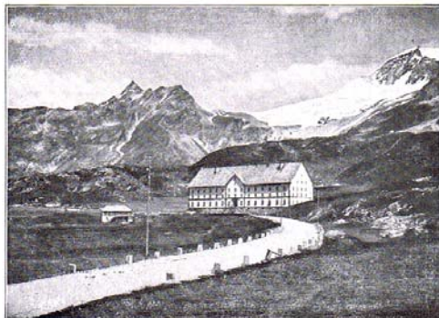
Route du Simplon : Le nouvel hospice.
